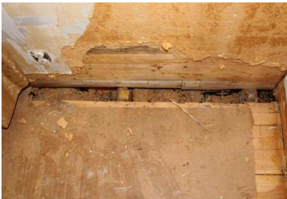
Bild 12. Golvplankan sågad och avlägsnad. Bjälklaget under golvet är fyllt med isolering i form sågspån. Ingen blodblandad vätska är synlig i sågspånet.
