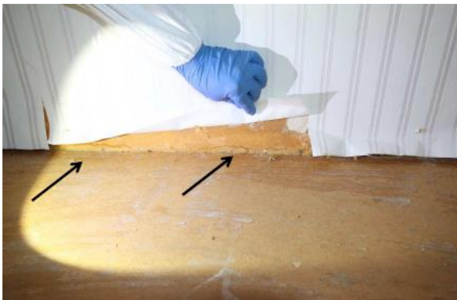
Bild 8. Tretextskivan i skarven mot golvet, på norra väggen nära nordvästra hörnet, har fuktfläckar efter att tidigare varit utsatt för väta. Liknande fläckar fanns längs norra väggen och västra väggen högra hälft. Fläckarna är förtestade mot blod utan resultat.
