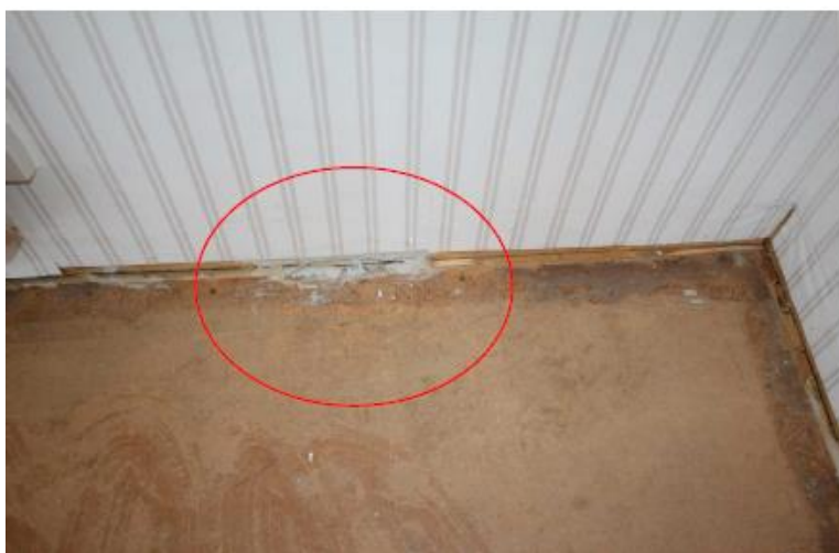
Bild 6. Spacklad yta på golvet mot västra väggen till höger om elementet. Golvmattan är avlägsnad.
